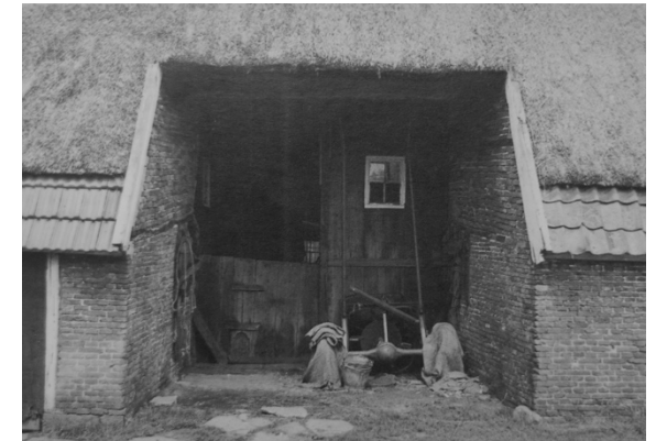
Figuur 3 Gebintwerk met ankerbalkconstructie - Onderschoer boerderij in Enter
