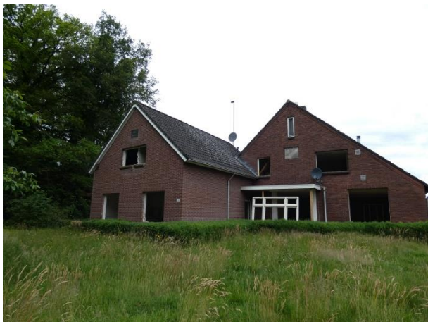
Afb. 32 Het vooraanzicht. Rechts het jaren twintig voorhuis (met latere aanpassingen), links de aanbouw uit de jaren tachtig.
