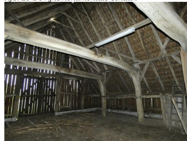
Afb. 30 Ankerbalkgebintconstructie van de schuur.
