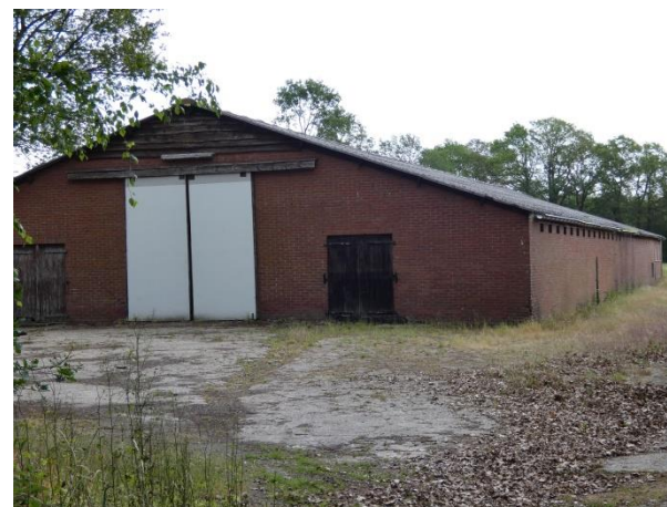
Afb. 49 Stal aan de Grote Veldweg, gezien vanaf de straat.
