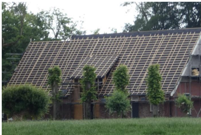
Afb. 28 Vier als windvang geplaatste oude bomen, langs de noordoostgevel van de Elkeman (recent geknot).
