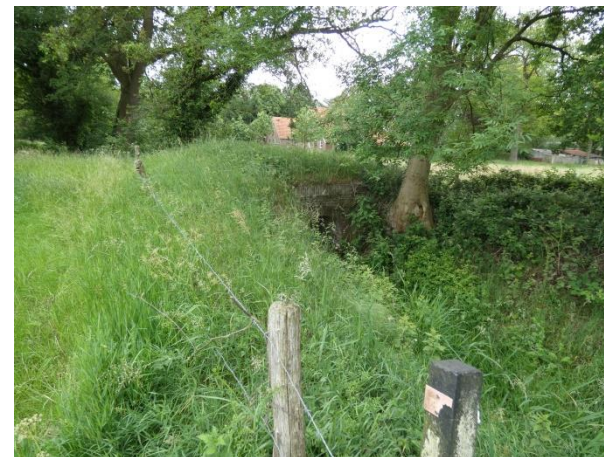
Afb. 55 Forse bakstenen duiker over de Elsbeek, gezien vanuit het westen.
