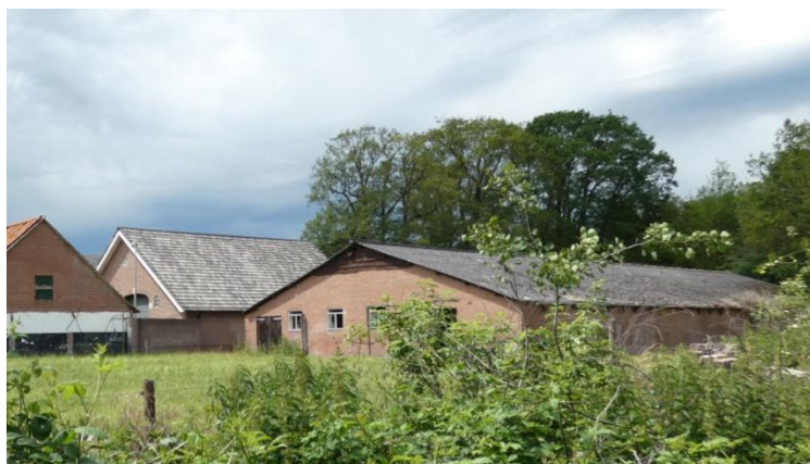
Afb. 50 Stal bij Grote Veldweg 50, gezien vanaf de ten noorden gelegen houtwal.
