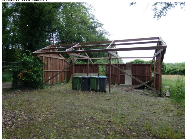
Afb. 45 Open garage (wagenschuur), langs de Tweekelerveldweg.
