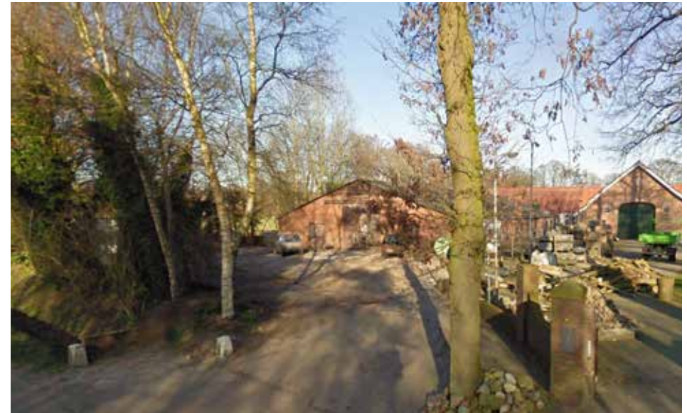
Afbeelding 30. Te slopen bijgebouwen op de locatie van het nieuwe beheergebouw.
