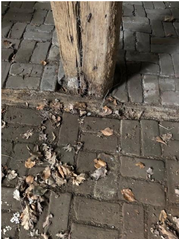
De balk welke in de vloer ligt.
