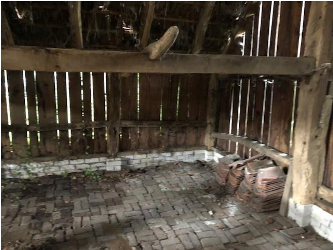
Metselwerk borstwering straatzijde
