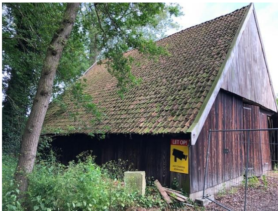
Straatzijde en toegangsdeuren
