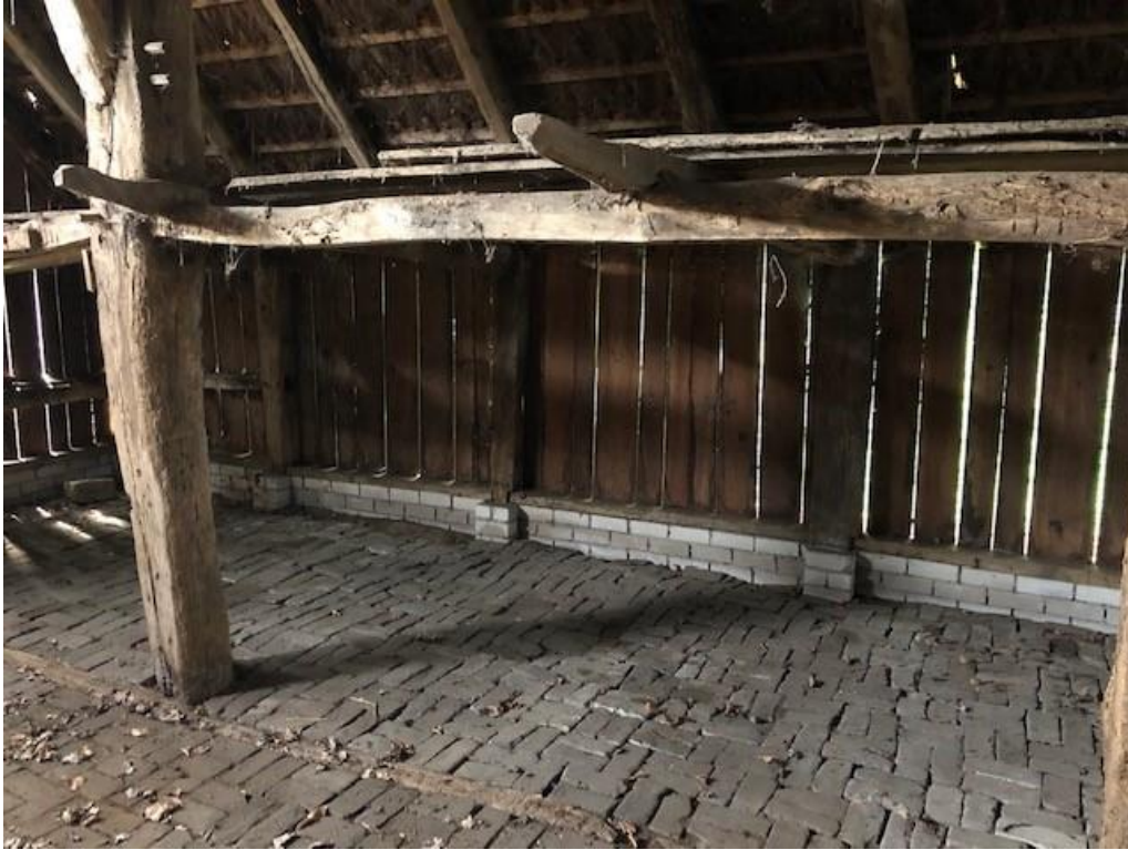
Metselwerk (kalkzandsteen) borstwering achtergevel
