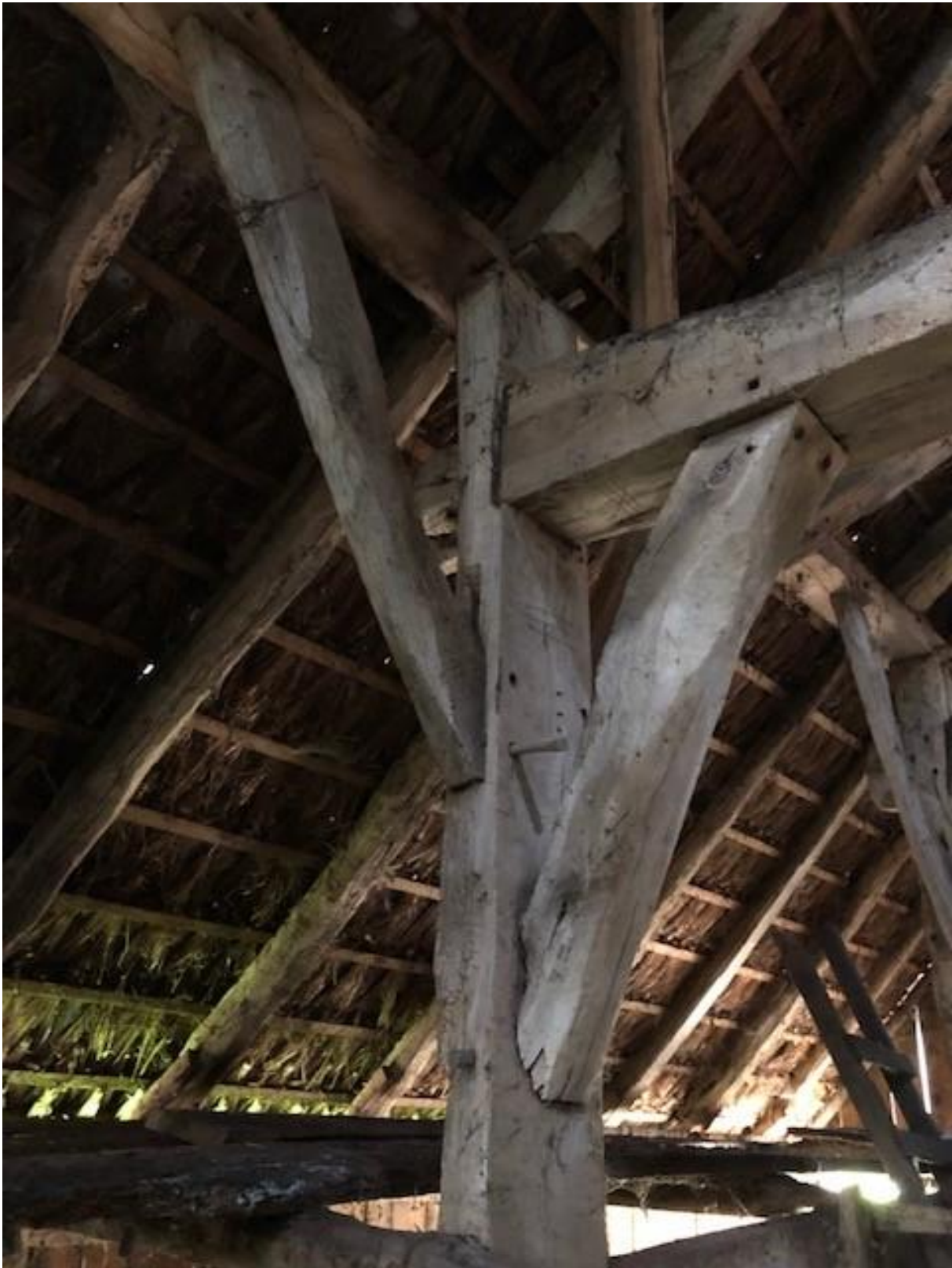
Detail eiken gebint. Hier is duidelijk te zien dat het gebintwerk is gemaakt voor enkel deze schuur. De doken zijn vrij lang en niet overal aanwezig.
