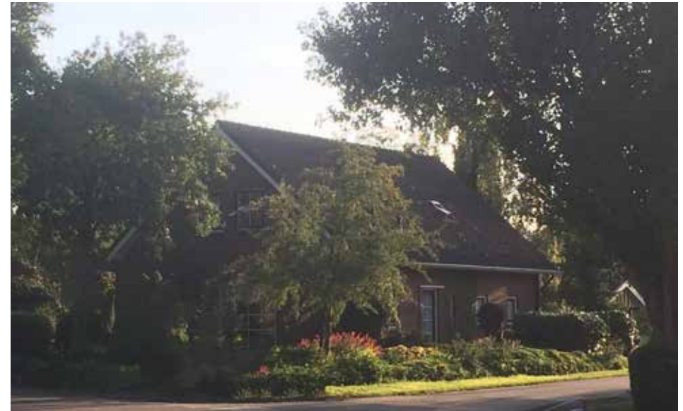
Afbeelding 25. Te slopen bebouwing aan de Bruninksweg
