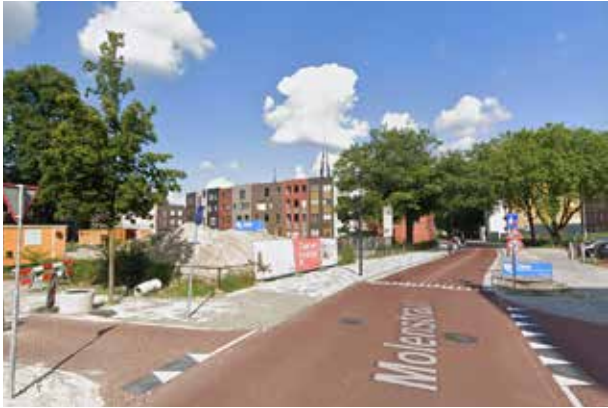
Nieuwe Molenstraat in aanleg zomer 2021
