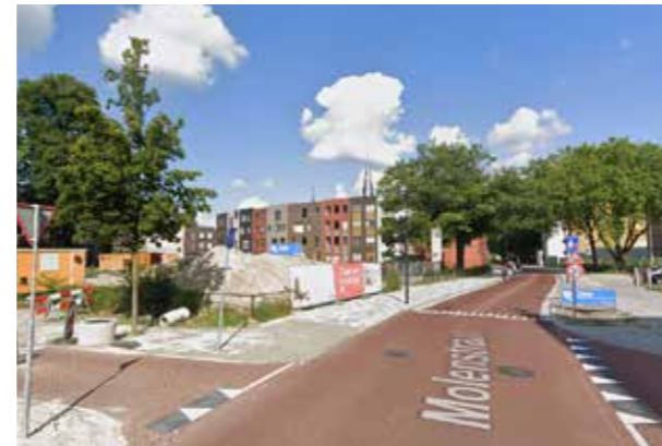
Nieuwe Molenstraat in aanleg zomer 2021
