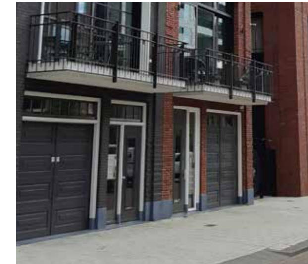
Garagedeuren of inritten zijn hoogwaardig vormgegeven
