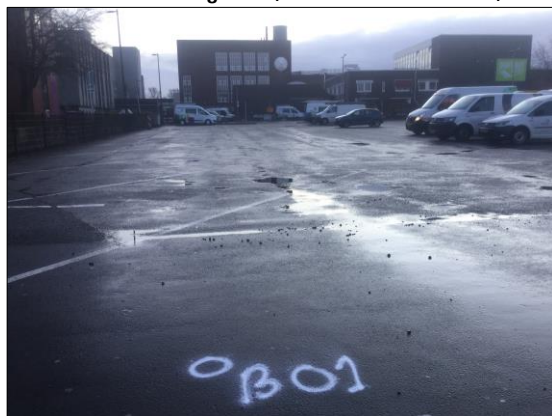
Foto 25: asfaltboring B01 (d.d. 19 februari 2020)
