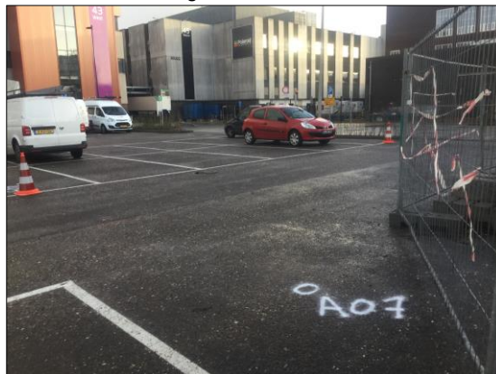
Foto 24: asfaltboring A05 (d.d. 19 februari 2020)
