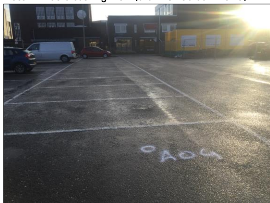
Foto 21: asfaltboring A02 (d.d. 19 februari 2020)
