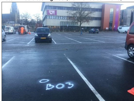
Foto 27: asfaltboring B03 (d.d. 19 februari 2020)
