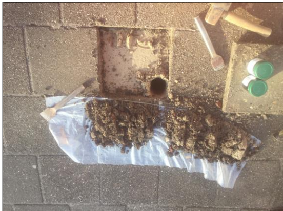
Foto 5: boring 04 (d.d. 19 februari 2020)
