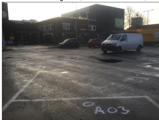
Foto 20: asfaltboring A01 (d.d. 19 februari 2020)
