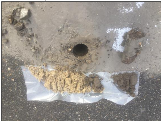
Foto 15: boring 12 (d.d. 19 februari 2020)
