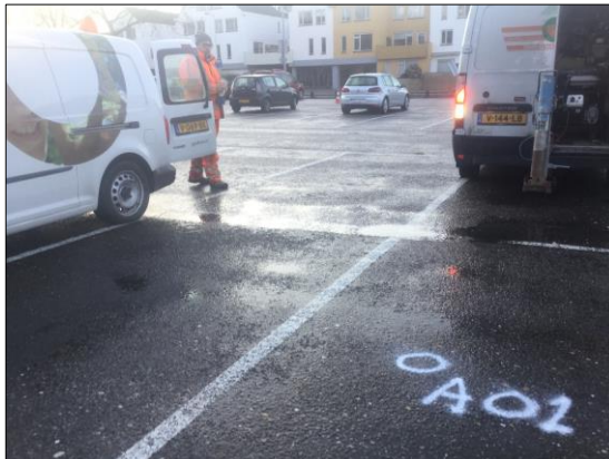
Foto 18: asfaltboring A01 (d.d. 19 februari 2020)
