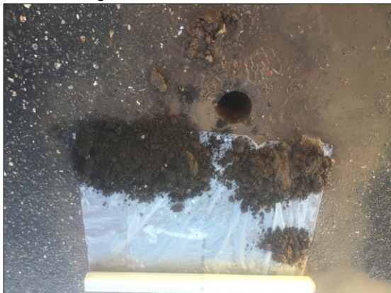
Foto 3: boring 02 (d.d. 19 februari 2020)
