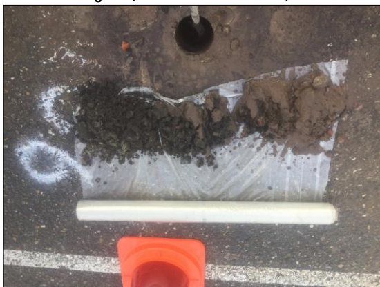
Foto 7: boring 06 (d.d. 19 februari 2020)
