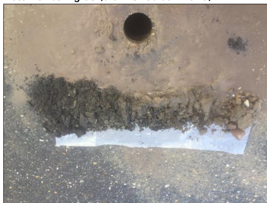
Foto 10: boring 09 (d.d. 19 februari 2020)
