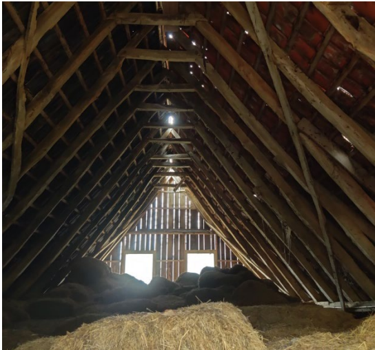
Afbeelding 4: Binnenzijde van de hooizolder in de paardenstal.
