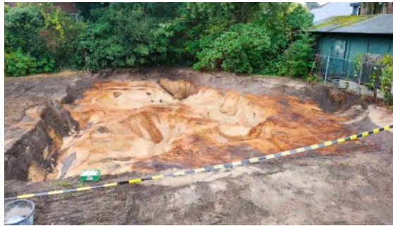
Foto 2 grillige ontgraving vanwege vele stortgaten
