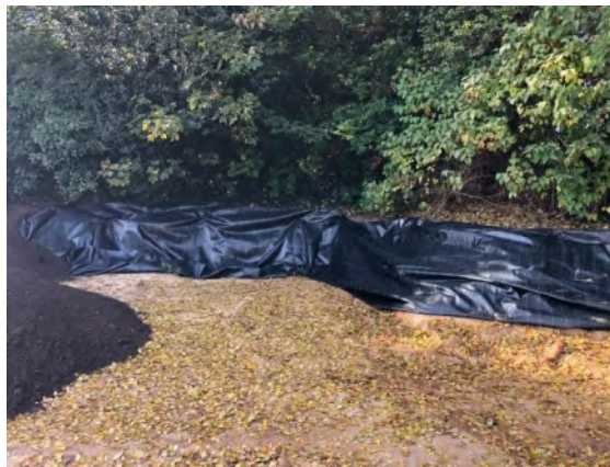
Foto 6 scheidingsdoek langs wand W2A
