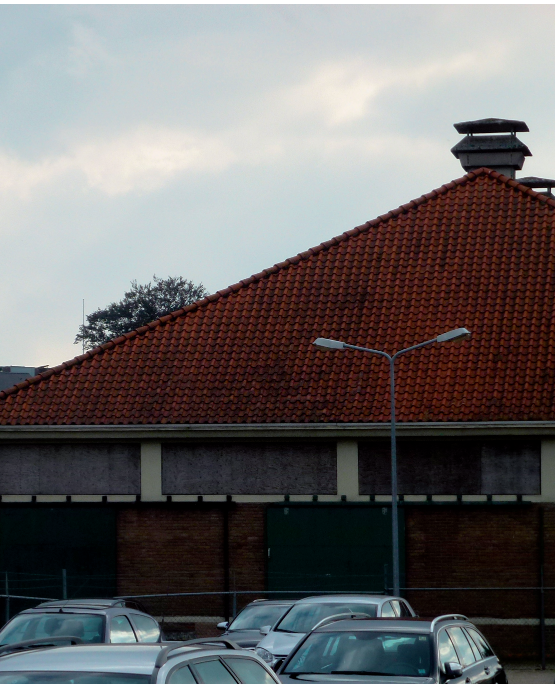
Gebouwen van de leegstaande Coberco- fabriek in Enschede, 2011.
