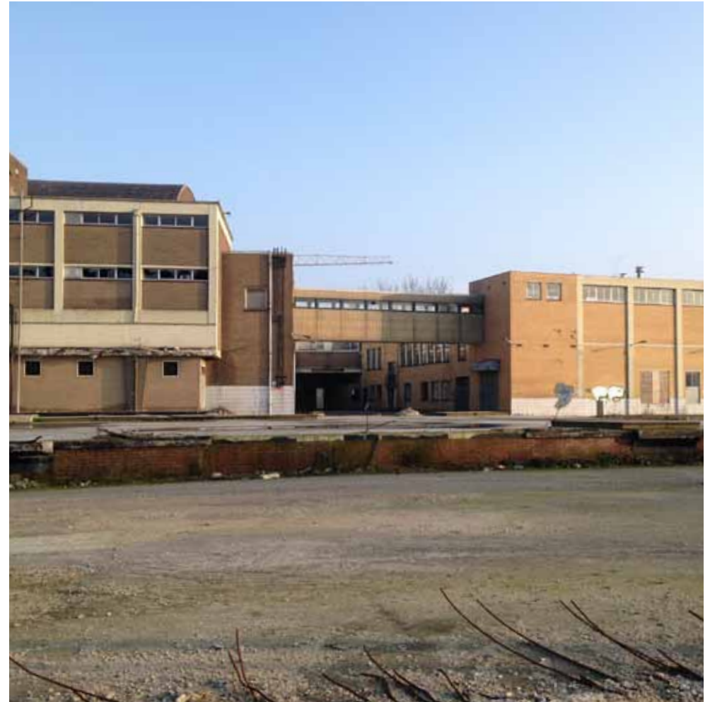
zicht vanaf de busbaan op de loopbrug
