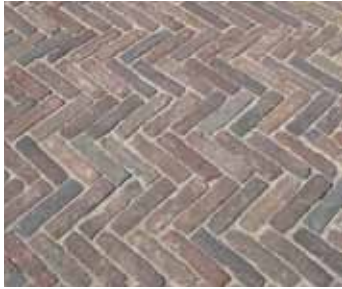
Klinkerbestrating keperverband in natuurlijke warme tint
