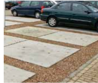
Betonplaten 2x2 mtr al parkeeraanduiding omringd door de bovengenoemde klinkerbestrating
