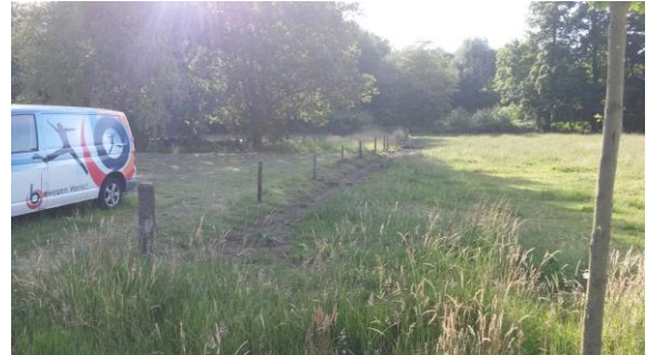
Aanleggen bocht en halfverharding
