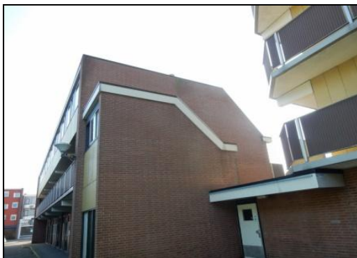
Figuur 3 Zijkant appartementengebouw.
