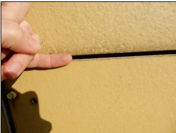
Figuur 10. De tussenruimte van de gevelbekleding is te klein voor vleermuizen om te passeren.
