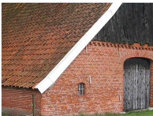
witte daklijsten, rode pannen en rodezwarte gevelplaten
