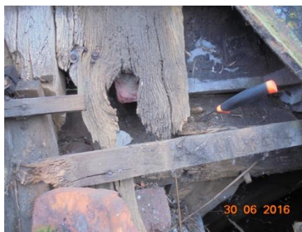
Houtrot rechter gebint plaat met aansluiting voorgevel.
