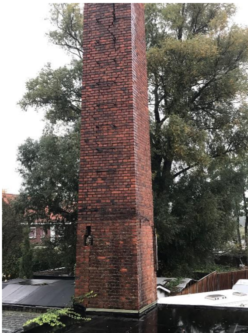
afb. 9 De schoorsteen vertoont veel schade en een grote doorgaande verticale scheur langs de klimijzers
