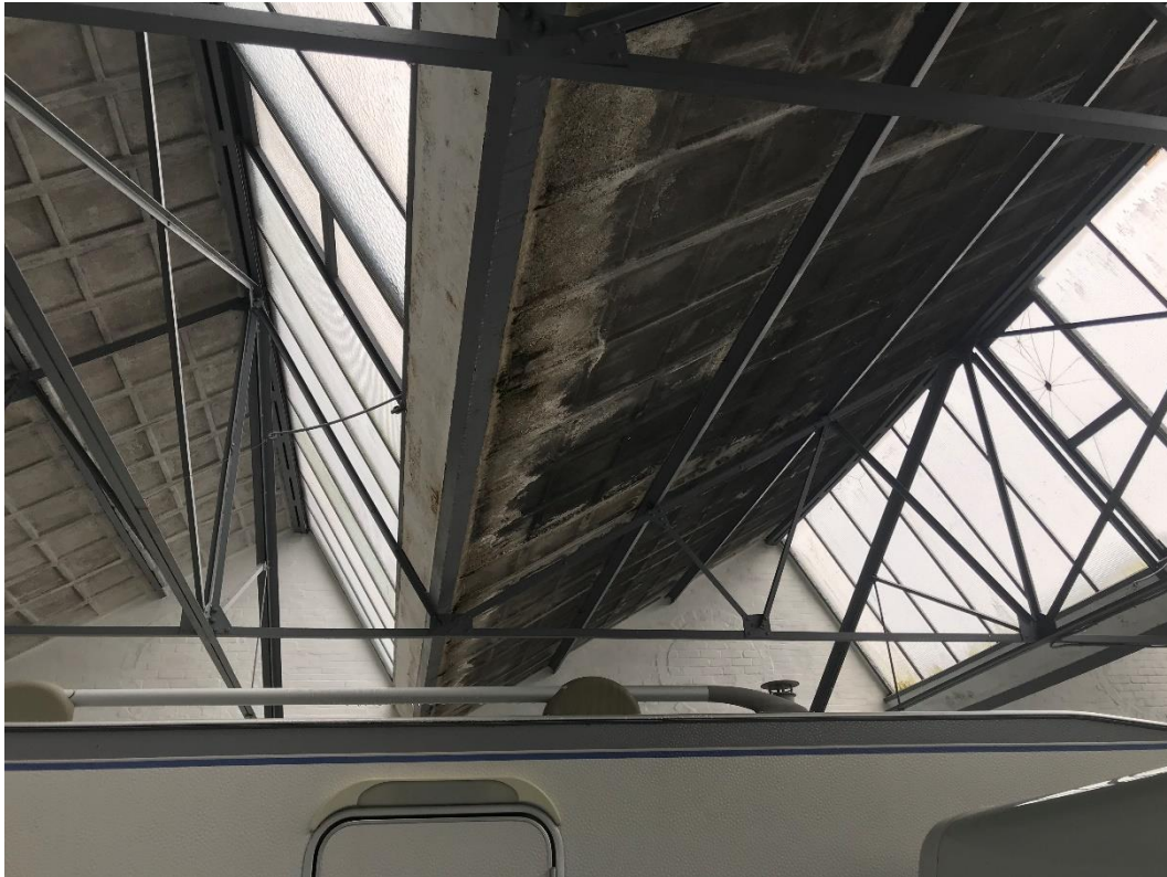
afb. 2 Impressie van het sheddak van het pand met de schokbetonnen dakplaten
