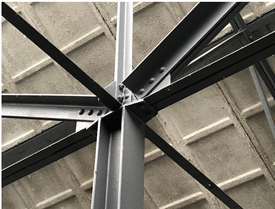
afb. 1 Knooppunt van de staalconstructie in een goede staat
