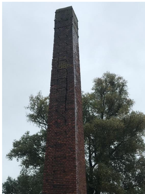
afb. 9 De schoorsteen vertoont veel schade en een grote doorgaande verticale scheur langs de klimijzers
