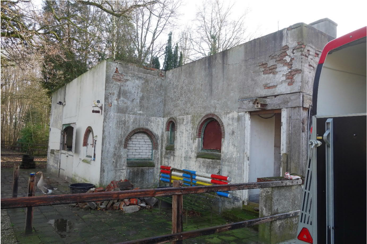
Zicht op de noordgevel vanaf het terrein achter het bedrijf Gronausestraat 645.
