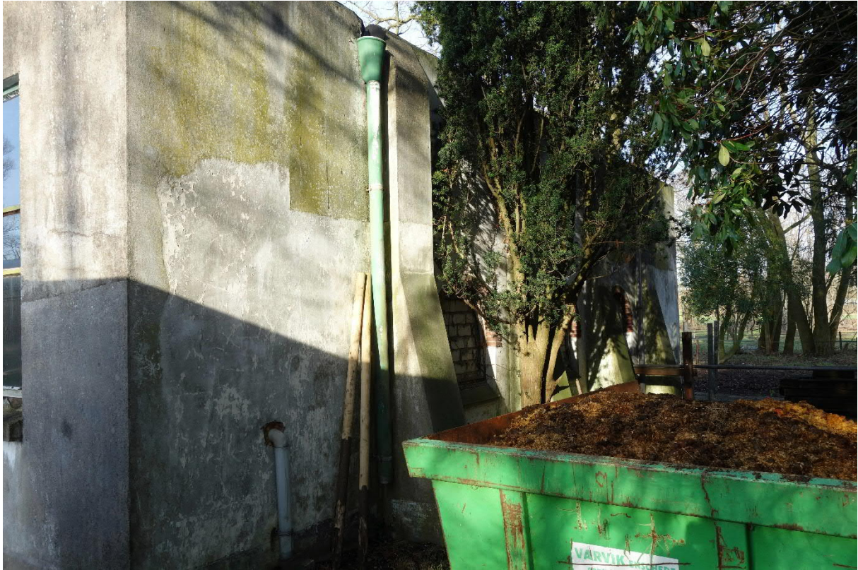
Zicht op de oostelijke gevel van het pandje.
