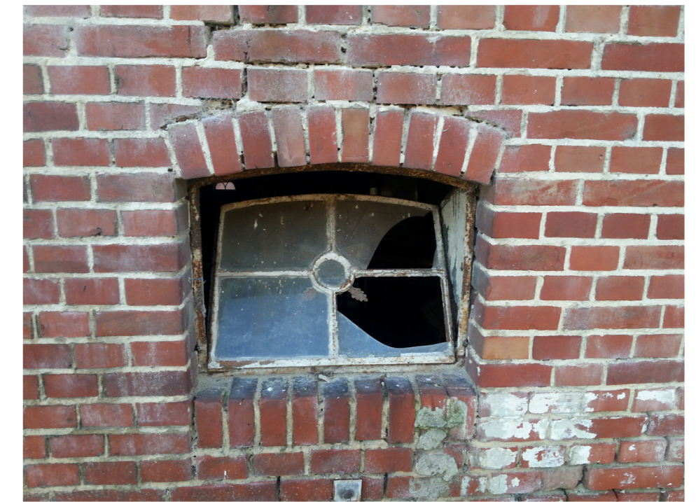
R: bestaande gietijzeren stalramen
