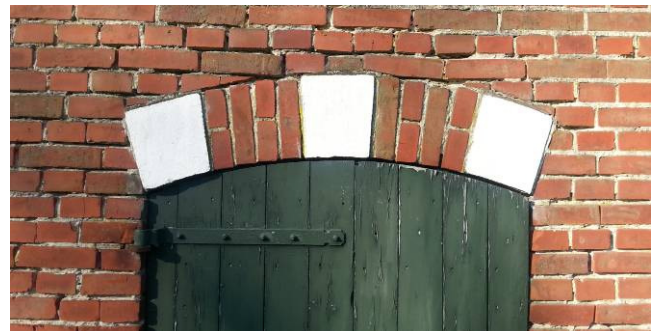
Foto : Strekse toog boven staldeuren
