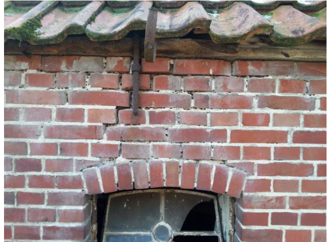
Foto : Gescheurd metselwerk in de hoek
