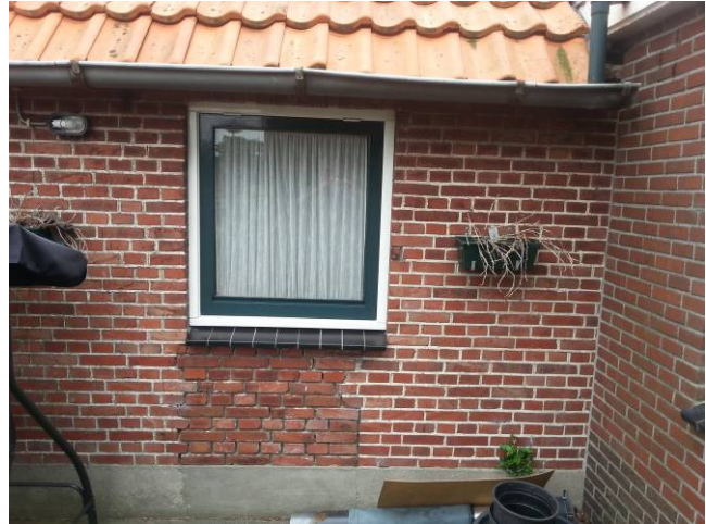
Foto : vervangen kozijn, verwijderde kelderkoekoek
