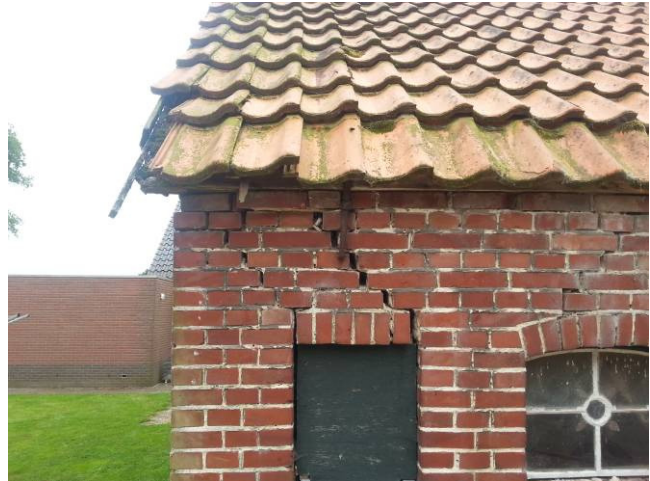
Foto : Gescheurd metselwerk in de hoek
