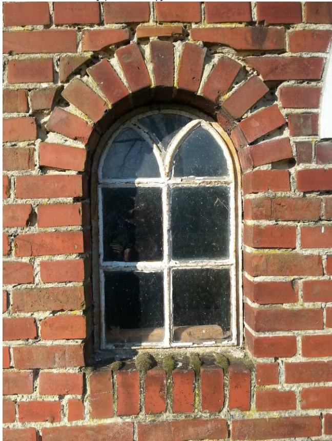
Foto : Detail lichtkozijn/kerkraampje
