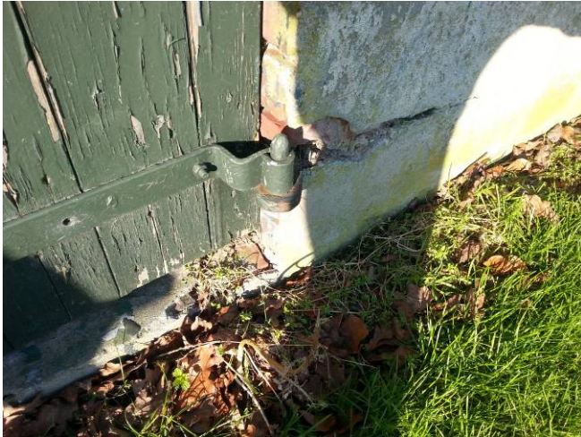
Detailfoto : Roestende duimen staldeuren
