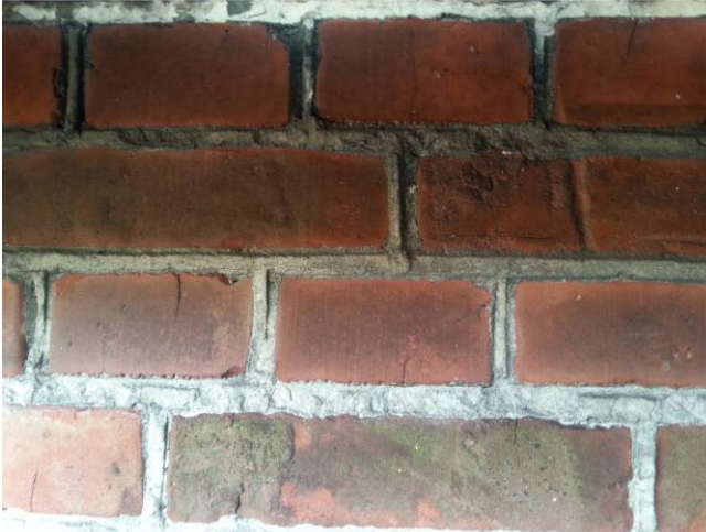
Foto : Detailfoto voegwerk
