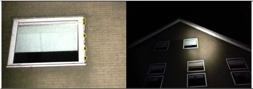
Figuur 3.2 Locatie verblijfplaats in gebouw C22.
