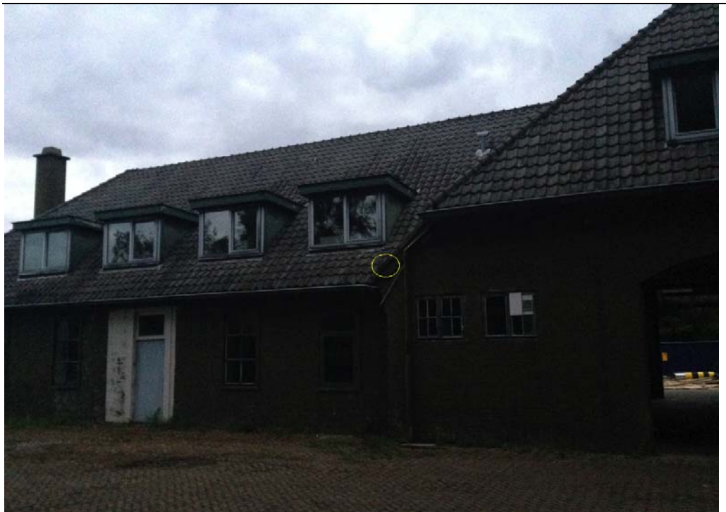
Figuur 3.3 Locatie verblijfplaats in gebouw C20.
