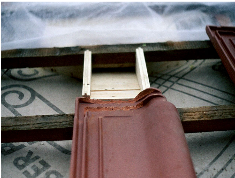
Figuur 7. Ingang van de kast gezien vanaf de onderzijde. De opstaande rand van de dakpan is deels verwijderd om de kast toegankelijk te maken. Belangrijk is dat de houten lat van het dak de ingang van de kast niet blokkeert. De lat moet 2 cm boven de bodem van de kast uitsteken. Bij een grotere opening kunnen vogels de kast gaan gebruiken. Een kleinere opening is slecht toegankelijk voor laatzvlieger.
