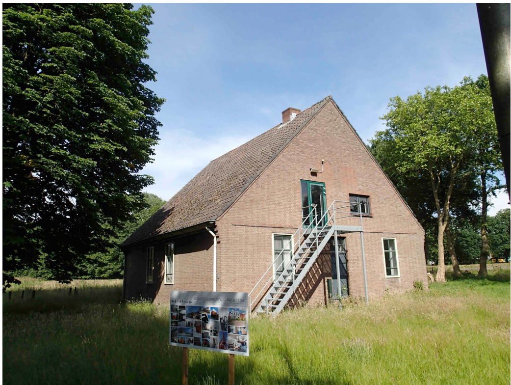
Figuur 1. Een van de gebouwen in het plangebied.
