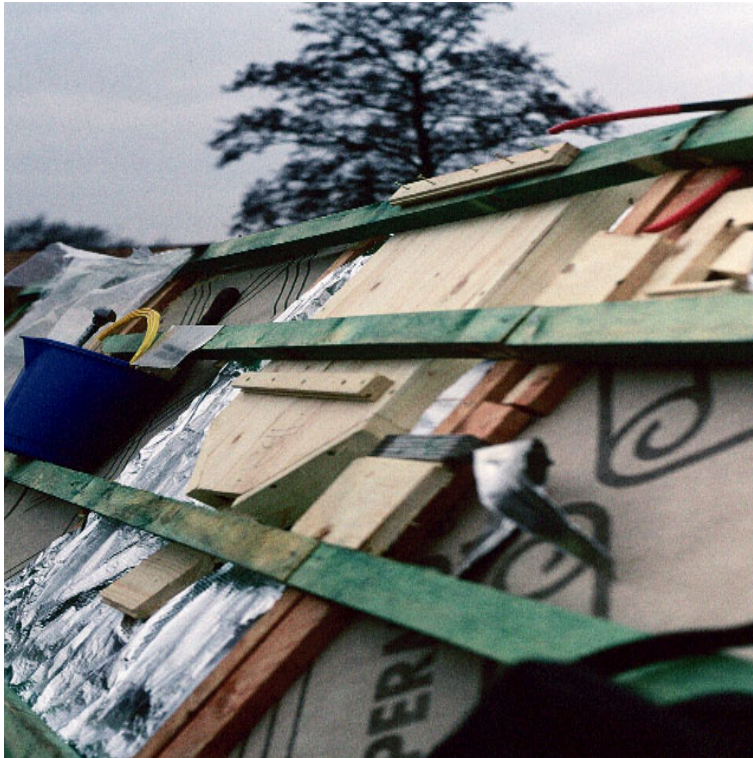
Figuur 6. Kast is helemaal bovenin het nieuwe dak geplaatst.
