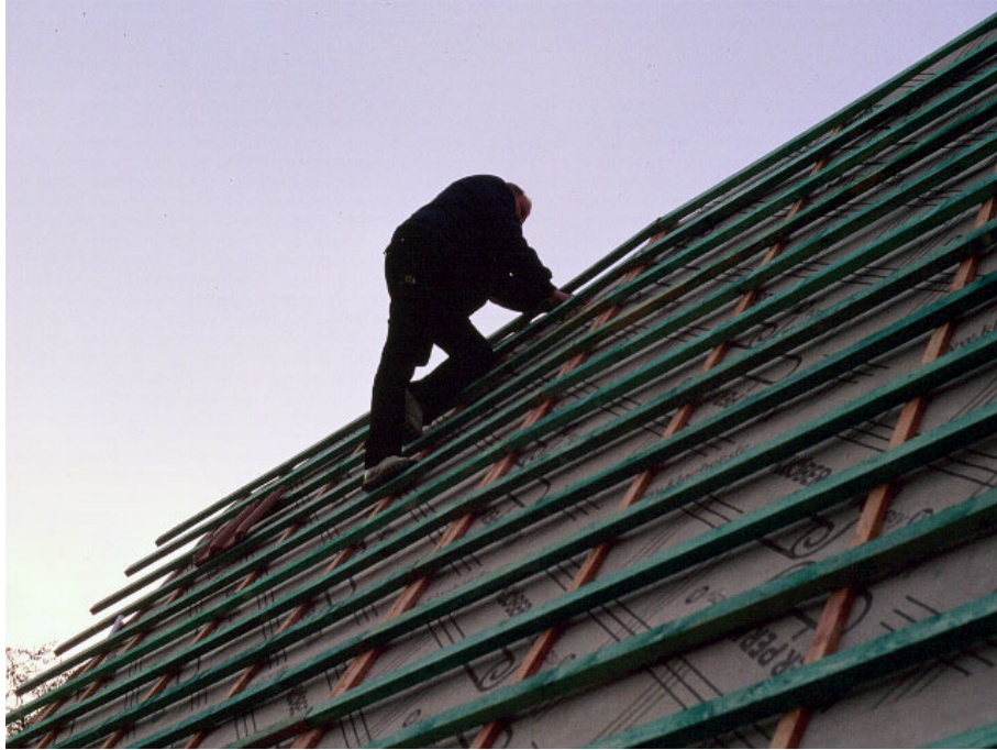
Figuur 4. Nieuwe dak met latten voor de dakpannen.
