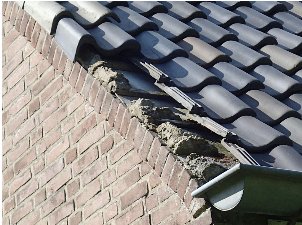
Figuur 3.5 De gebouwen in het plangebied hebben dikke muren zonder spouw.
