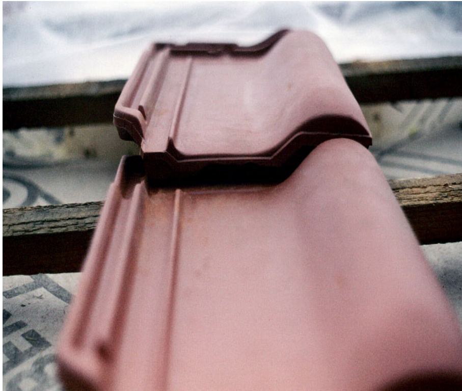
Figuur 8. Nieuwe dakpannen liggen op de kast. De pannen sluiten niet precies. Opnieuw is een opening van 2 cm nodig om de kast toegankelijk te maken voor laatvliegers. De onderste dakpan dient opgeruwd te worden zodat vleermuizen erop kunnen kruipen (niet weergegeven).
