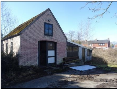
Figuur 3. Bebouwing met golflaten dak.
