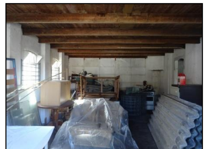
Figuur 8. Binnenzijde van de bebouwing.
