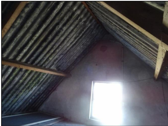
Figuur 11. Onder de golfplaten is geen beschot aanwezig, waar vleermuizen gebruik van kunnen maken.
