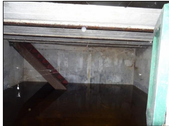
Figuur 12. De kelder is vanwege de slechte toegankelijkheid niet geschikt om te dienen als verblijfplaats voor vleermuizen.
