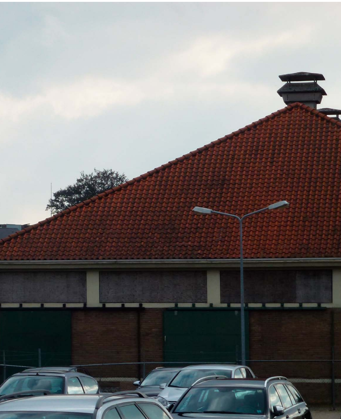
Gebouwen van de leegstaande Coberco-fabriek in Enschede, 2011.
