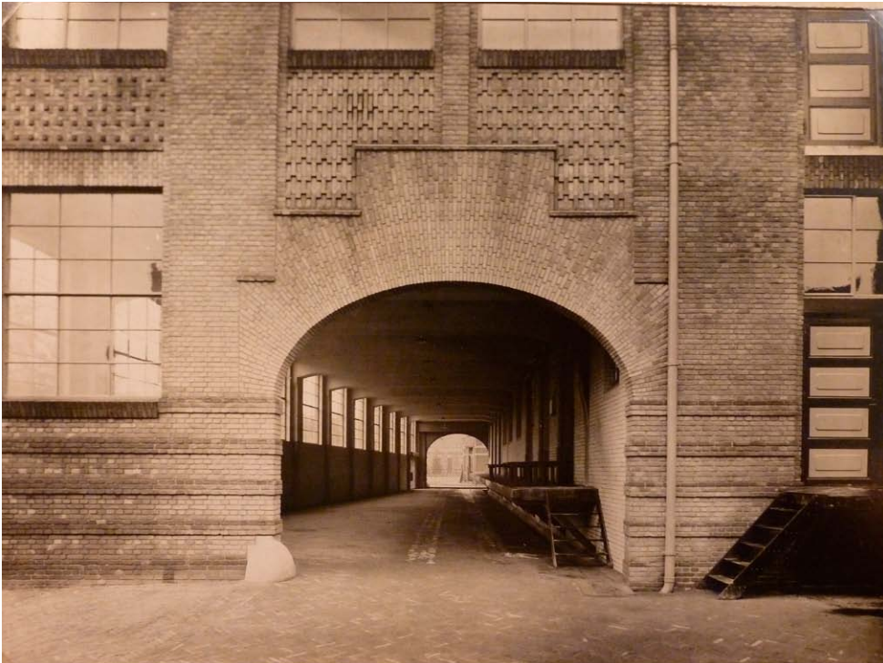
Doorrit voor de melkontvangst: aan het begin van de doorrit staan 2 bascules voor het wegen van de melk, aan het einde van de doorrit bevindt zich de afgifte van de ondermelk. Op de foto is het begin van de doorrit te zien. [SAE]
