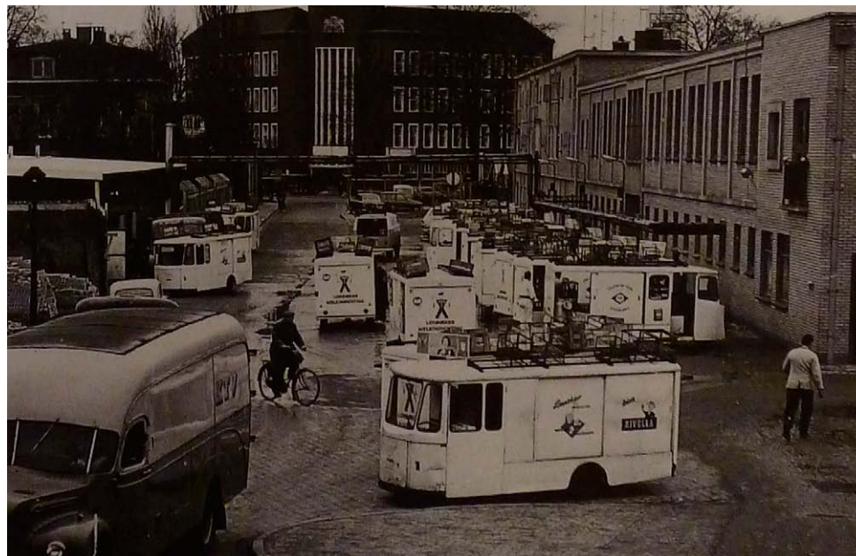
Geparkeerde ventwagens aan de Raiffeisenstraat, 1965. [RAZ]
