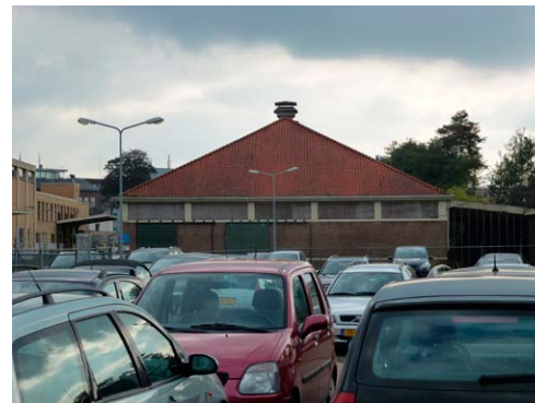
Noordzijde van de kunstmesthal gezien vanuit de Kottendijk.
