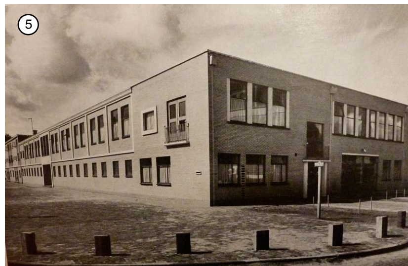
Nieuwe kantoorgebouw Lonneker Coöperatieve Melkinrichting, gezien vanuit de Eerste Hengelose Dwarsstraat, omstreeks 1960. [SAE]
