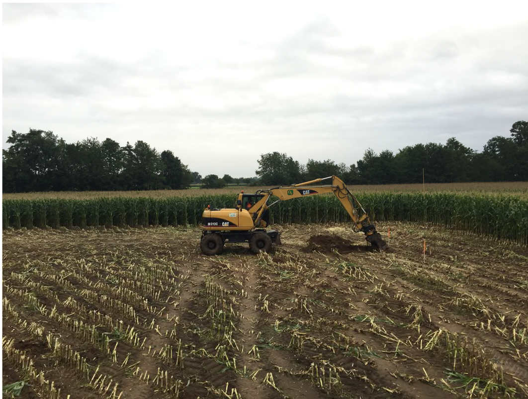
Afbeelding 12. Aanleg van werkput 3. Fotorichting: noordoost.
