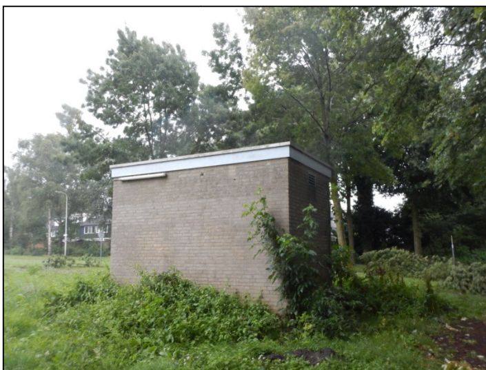
Figuur 6. Trafohuisje dat gesloopt gaat worden.
