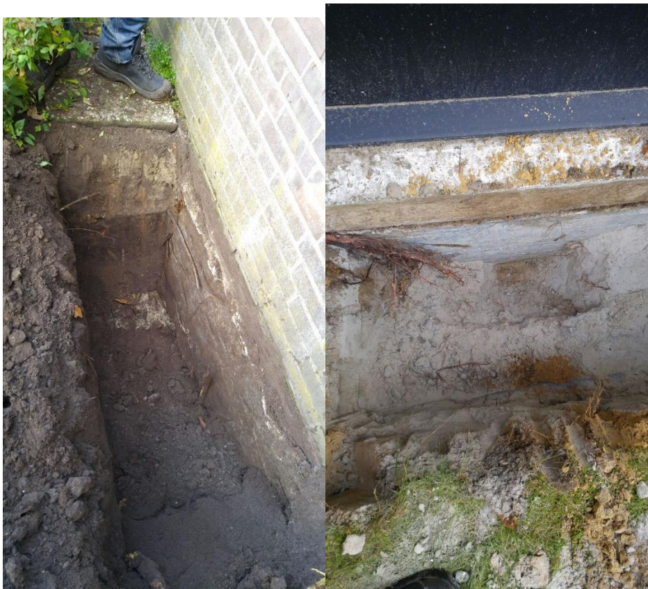
Afbeelding 3. Verstoorde bodem langs en onder de funderingsbalken aan de noordzijde van het DCW gebouw. Ook in boringen aan de noordzijde van het gebouw is een diepe bodemverstoring vastgesteld.
