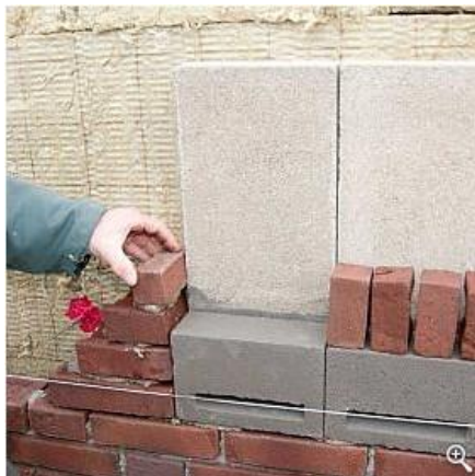
Figuur 3. Plaatsen inbouwkasten
