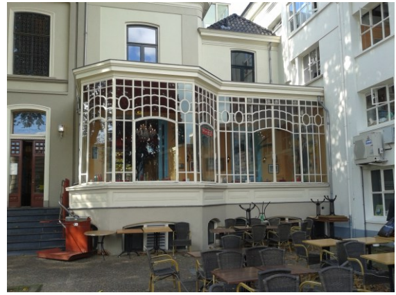
Serre aan de achterzijde
