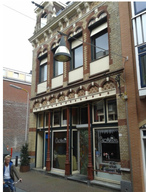
Zuiderhagen 33/35, bouwjaar 1899. Gietijzeren pilaren in de voorpui, zeer gave en rijke detaillering, fantastisch materiaalgebruik qua stenen, fraai uitgevoerde daklijst en dakkapel.
