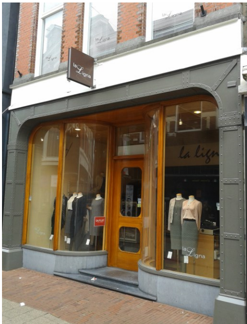
Haverstraatpassage 20, bouwjaar 1889. Pui met tweezijdig gebogen ramen en ijzeren omlijsting, geïnspireerd door de bouw van de Brooklyn Bridge 1883 en Eiffeltoren 1889; zeer authentiek.
