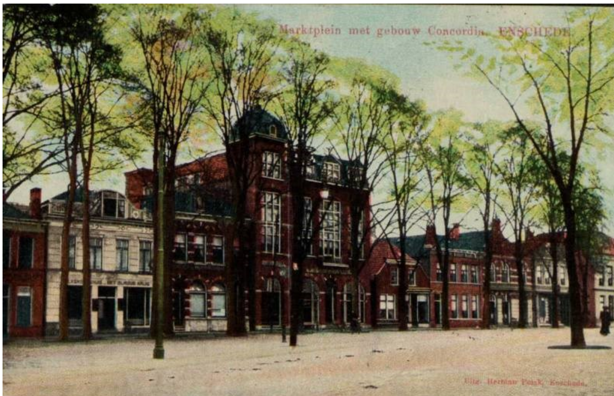
Ansicht uit 1909 met de noordelijke gevelwand. In het midden het oude Concordia-gebouw, dat in december 1909 afbrandde en op dezelfde plek in gewijzigde vorm herbouwd is
