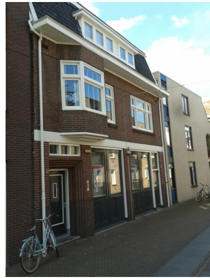
Voorgevel pand nummer 51A/53
