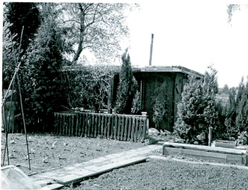
Foto 4- Tuinhuisje centraal op het perceel (pijp asbesthoudend)
