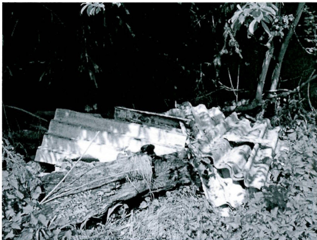
Foto 5 Asbesthoudende dakplaten (zuidwestelijk op perceel)
