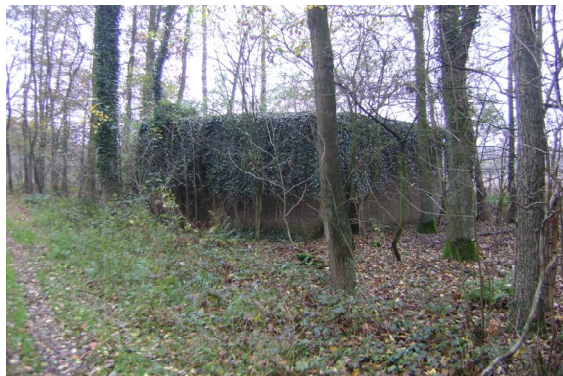
Foto's 12 t/m 15. Voorbeeld van objecten binnen het deelgebied Vliegveld die mogelijk ingericht kunnen als (winter)verblijfplaats voor vleermuizen.
