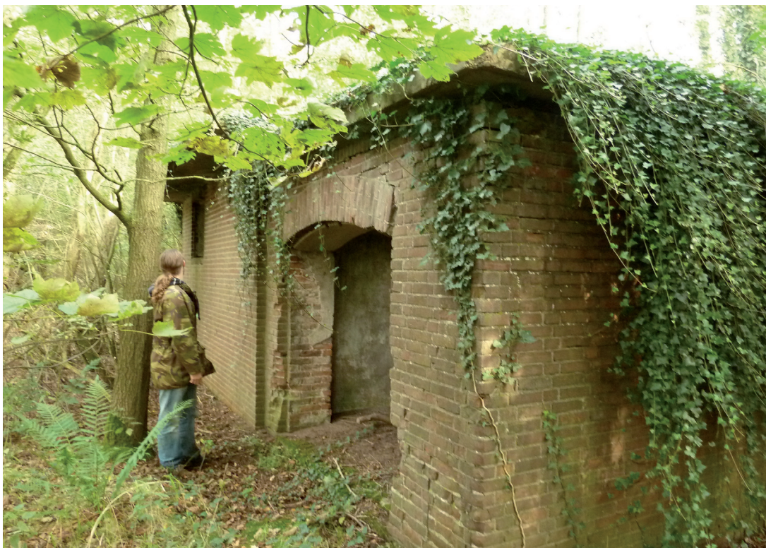
Figuur 19. Een zeer authentiek ogend Duits gebouw met garage en beerput is als ruïne nog aanwezig. Waarschijnlijk gaat het om gebouw 89a in de inventarisatie van het Oversticht en heeft het een relatie met de Liegeplatz in dit gebied (inspectie nr. 14).
