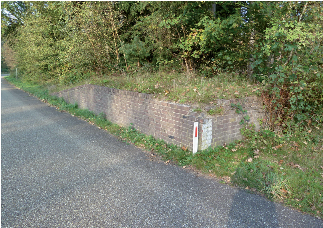
Figuur 16. Een helling van baksteen in deelgebied 1 in het voormalige Liegeplatzgebied (inspectie nr. 8) In Oostkamp ligt eenzelfde helling.
