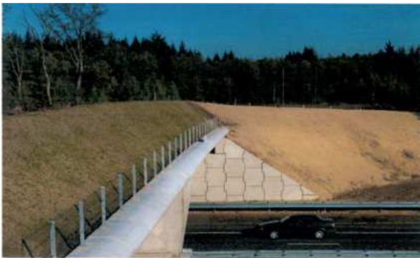
Voorbeeld van het J.P. Thijsse ecoduct over de A12. Een vegetatietalud achter een slanke rand.
