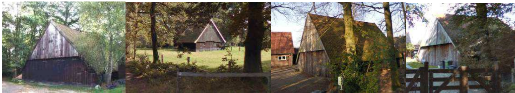
Vakwerkschuur/Schuilkerk, Haimersweg 225 (rijksmonument)
