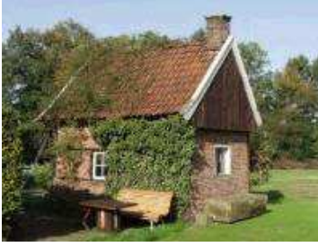
Vakwerk Bakspieker; Hellerweg 5 (rijksmonument)
