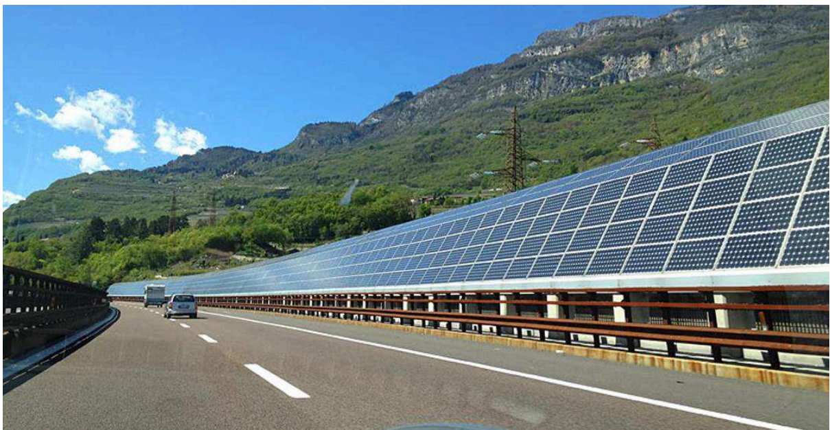
Afbeelding 14: Zonne installatie langs de "Brennerautobahn" in Italië
