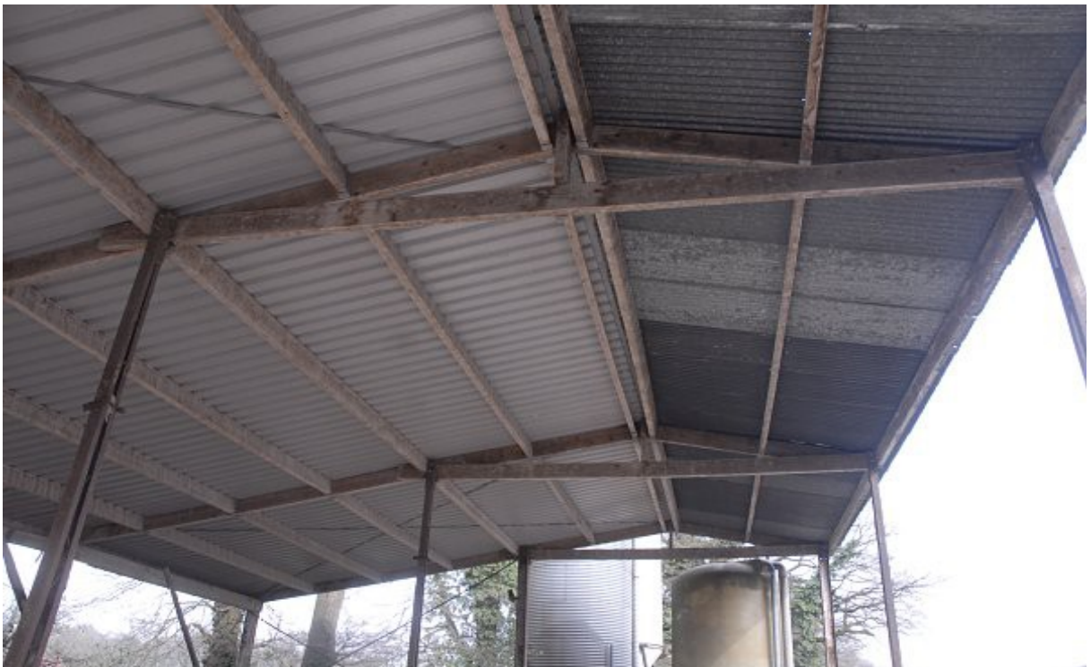
Afbeelding 4. Constructie ongeschikt voor broedvogels.
