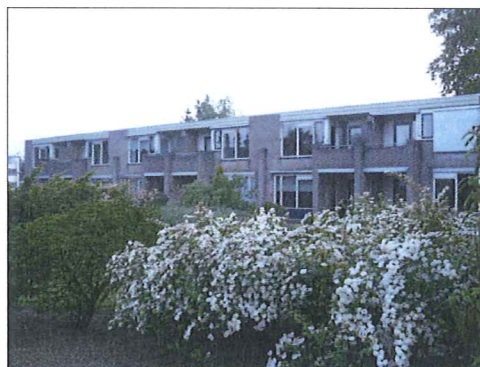
Figuur 1: zorggebouw op de onderzoekslocatie.
