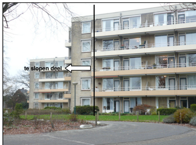
Figuur 2: Het westelijke deel van het pand wordt gesloopt.
