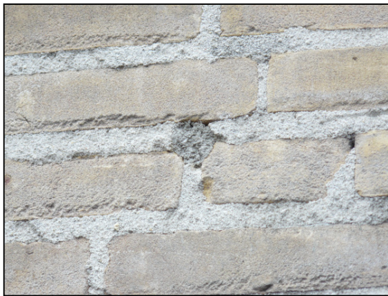
Figuur 4: De spouwruimte is opgevuld met isolatiemateriaal.
