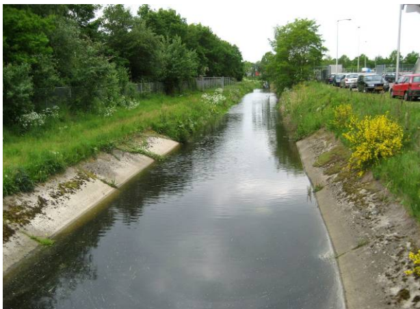
Foto 2: watergang tussen stadion en RWZI
