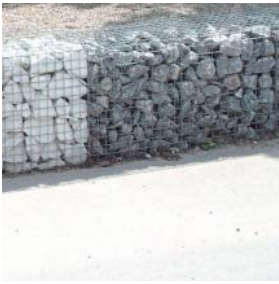
k1, duikerbrug, beton en schanskorf 1000 mm breed
