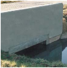
k1, duikerbrug, beton en schanskorf 1000 mm breed
