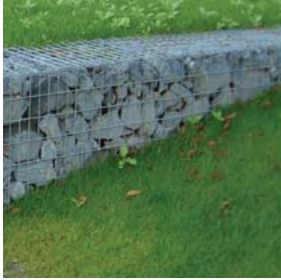
k2, beëindiging greppels dwarswegen bolling, schanskorf 1000 mm breed
