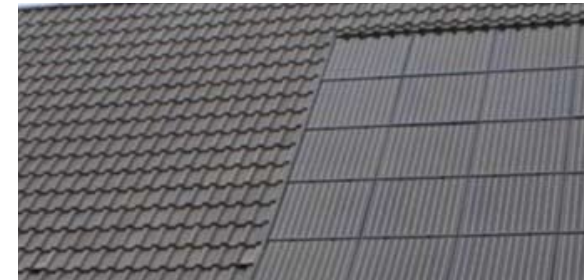
Zonnepanelen geïntegreerd
