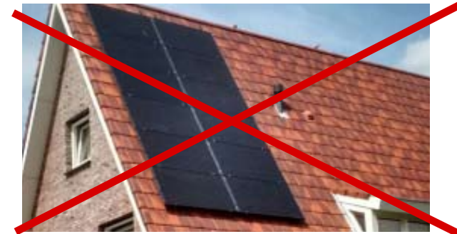
Antraciete zonnepanelen op rode pannen niet toegestaan
