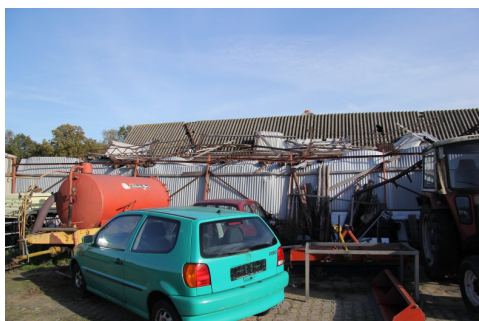
Figuur 14. Achterzijde van de varkensstal met ingestorte stalling.
