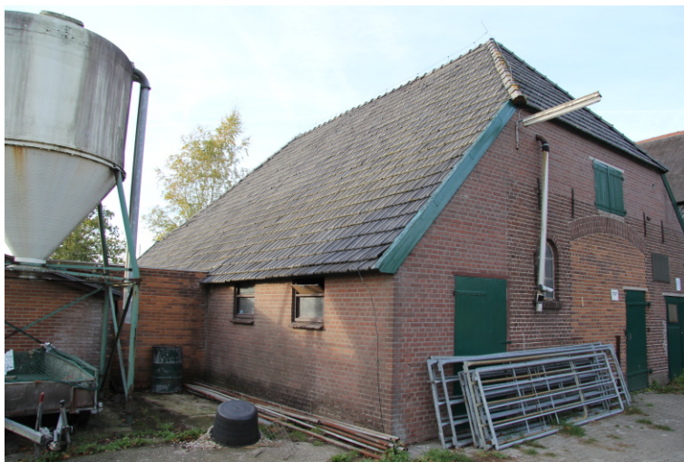
Figuur 1. Zuidelijke, te renoveren deel van de boerderij met op de voorgrond de zuidoosthoek.
