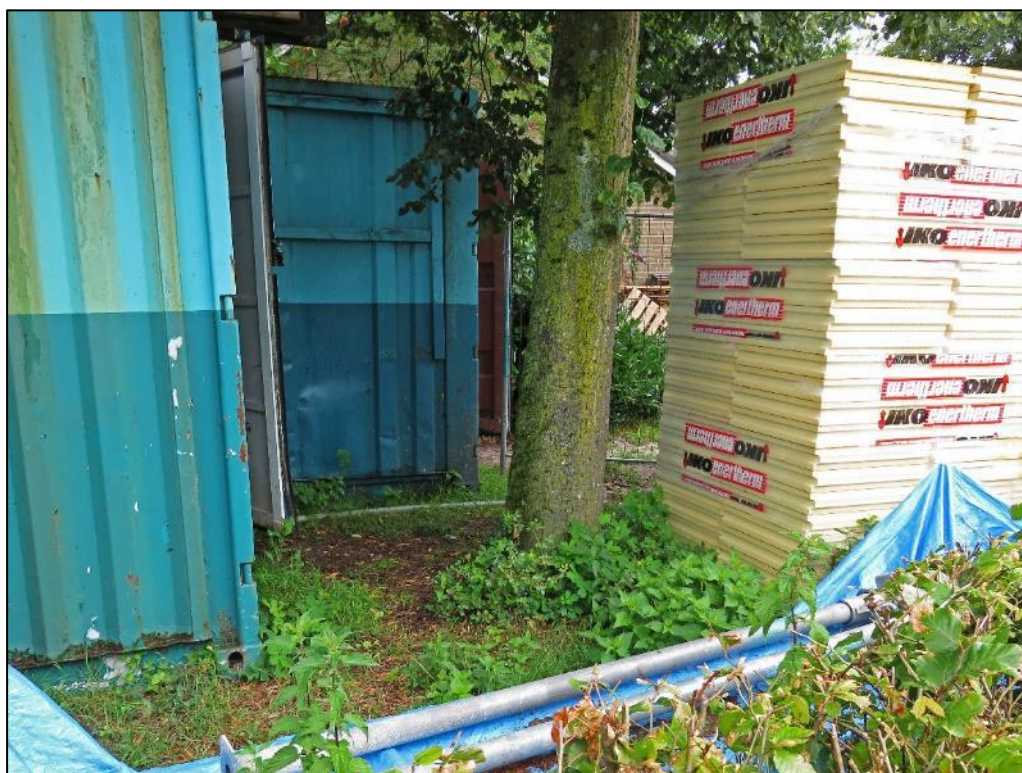
Figuur 6 Opslag van materialen rond boom 8
