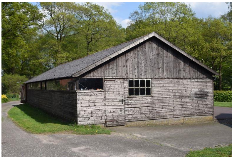
Figuur 6: Karakteristieke schuur
