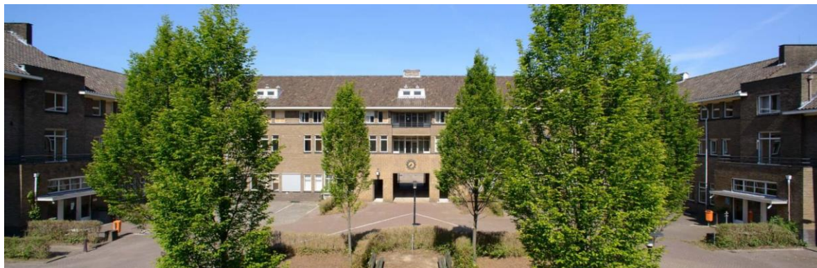
Figuur 2: Zicht op de binnenplaats van het huidige SMCD gebouw
