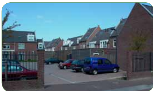
parkeren in parkeerkoffer tussen de woningen
