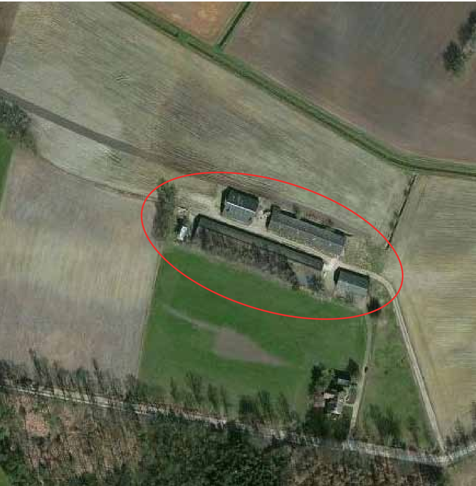
Afbeelding 1. Luchtfoto huidige situatie
