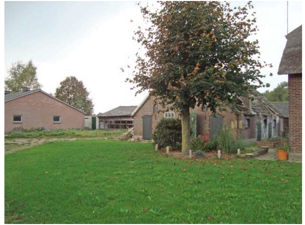
Foto 2. Voorzijde erf met vlnr gebouw 5, 6, 2 en 1.
