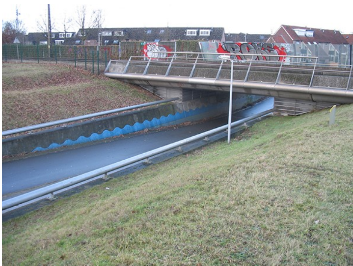
Fietstunnel onder de spoorlijn richting Almelo.
